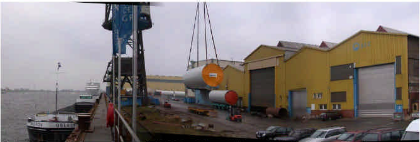
Verladen der Windenergietürme bei SSC auf dem Vulkangelände in Bremen Nord. (c) by UH/0311
