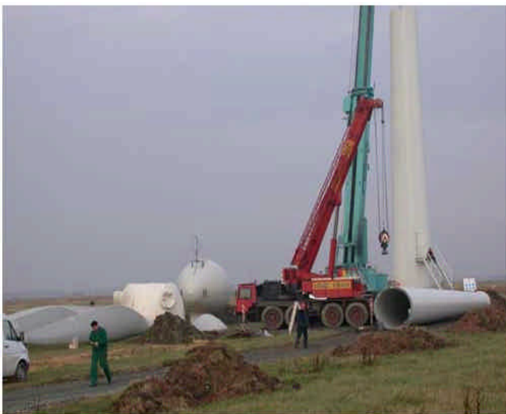
Aufbau einer "ENERCON - E40" Windenergieanlage (c) by UH/0311
