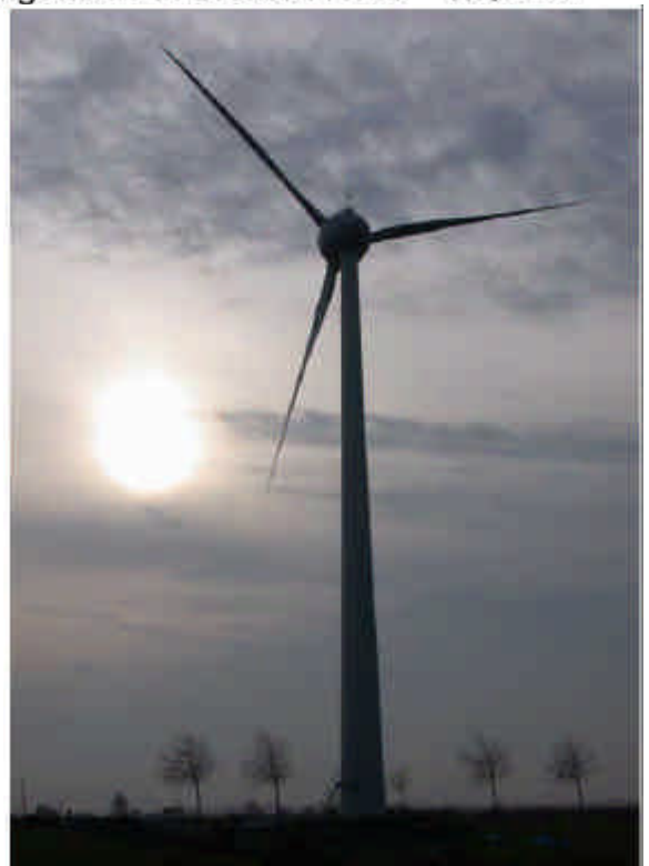
Eine ENERCON E-40 fertig montiert (c) by UH/0311 Nabenhöhe 65m, Rotordurchmesser 40 m, Leistung 600KW
